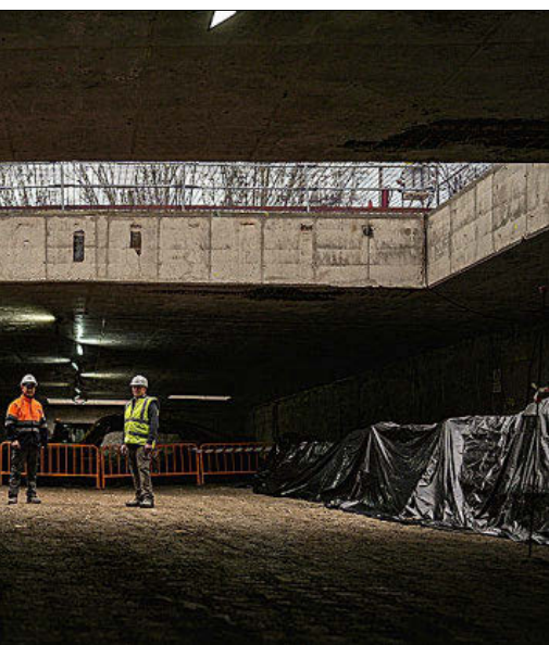
Instantáneas de trabajadores construyendo lo que será la futura estación de Madrid Río. CAM
