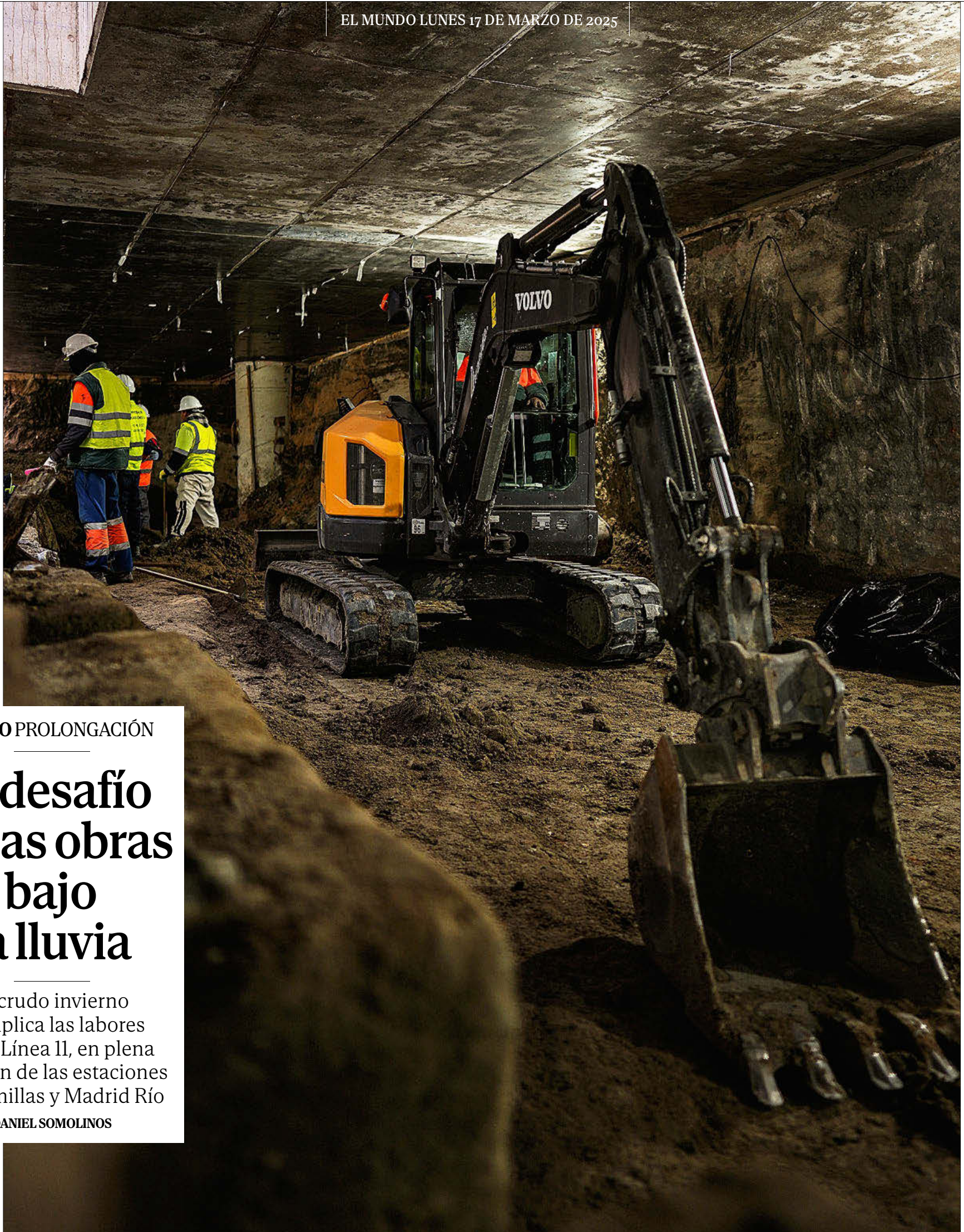
Operarios trabajan en el vestíbulo de la futura estación de Madrid Río. CAM
