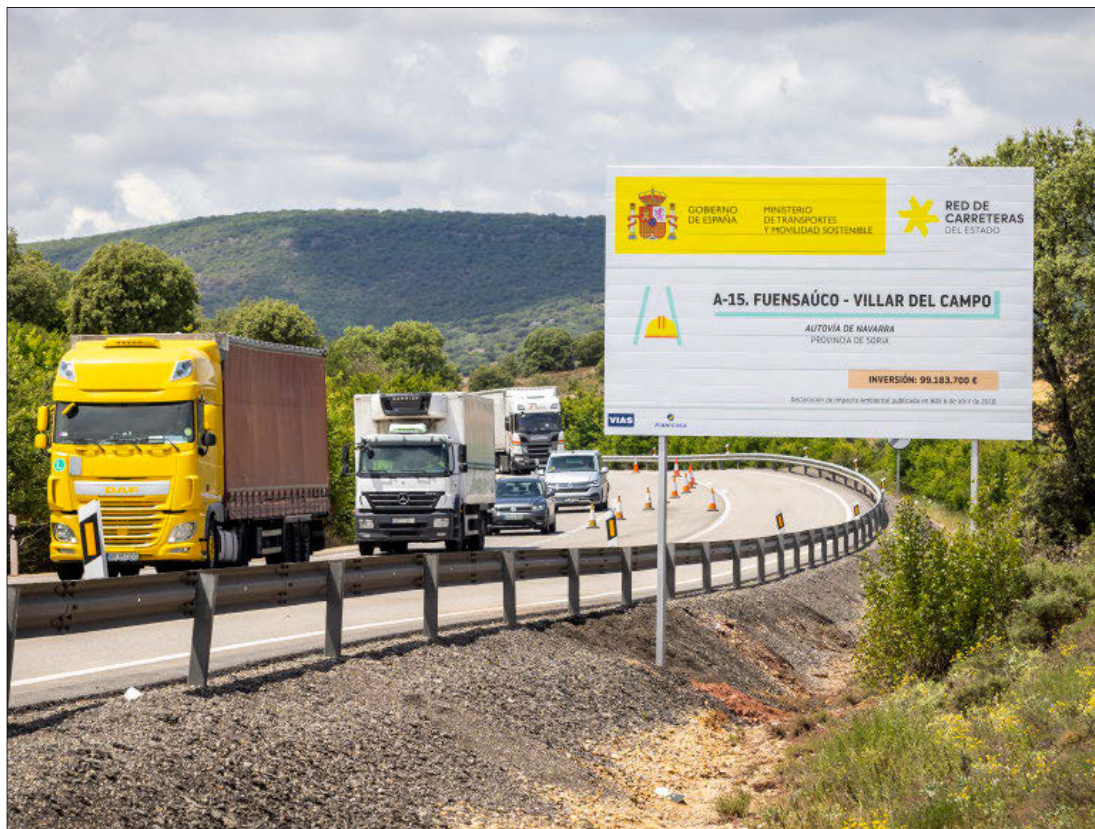
Cartel del Ministerio sobre las obras del tramo Fuensaúco-Villar junto a la N-122. MARIO TEJEDOR
